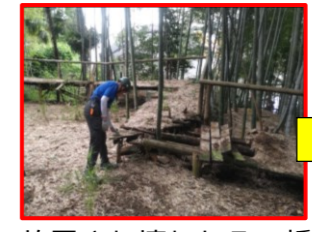
放置され壊れた八つ橋
