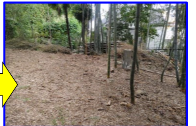
全撤去 (釘・板分類、市で回収)
