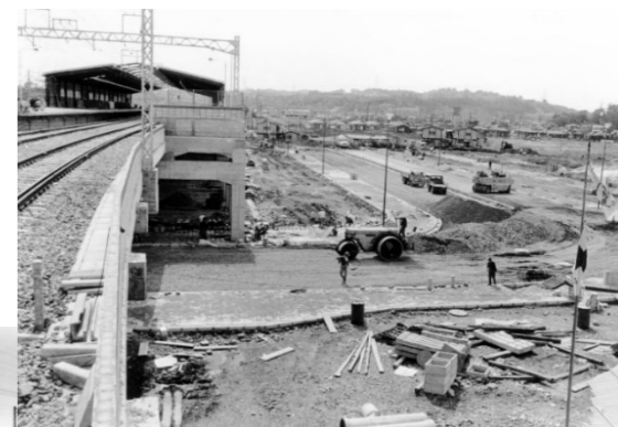
1969(昭和44)年 建設中の高架駅
